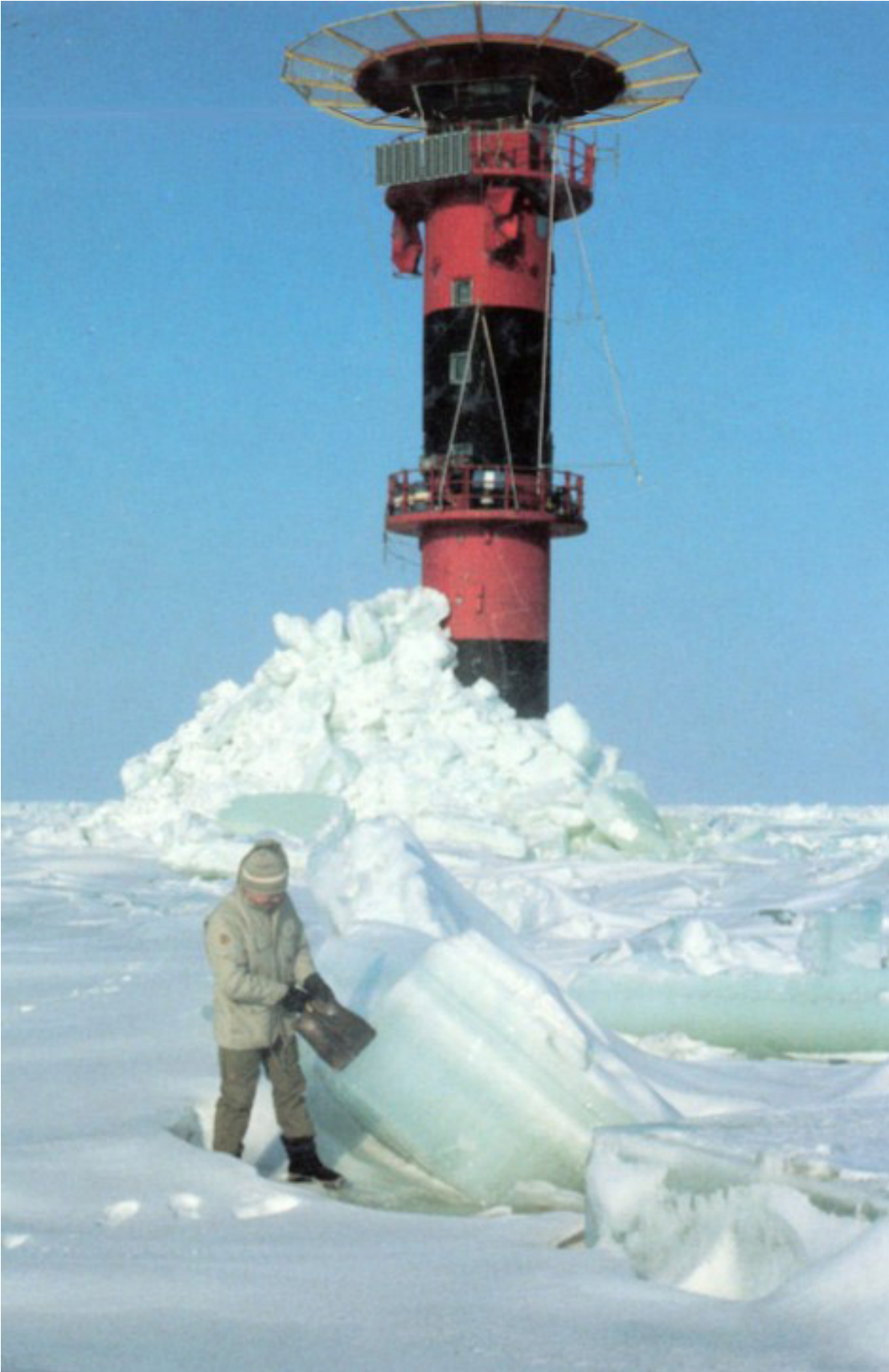
Jäät ovat kasautuneet kartiolle varustettua Kemi I majakkaa vasten. Jäämassa on pohjautunut majakan jalan päälle, mikä on vaikuttanut nousukorkeuteen. Etualalla päällekkäin ajautunutta ja yhteen jätynyttä jäätä.
