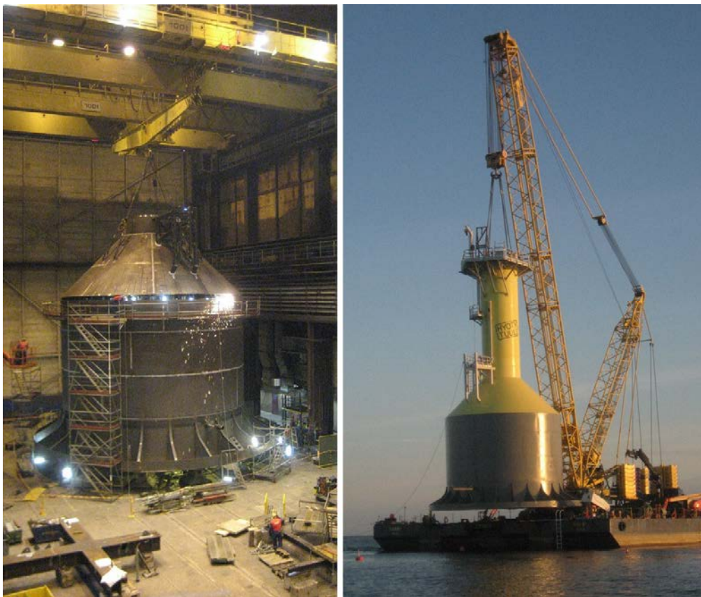
Tahkoluodon pilottivoimalan valmistusta ja asennus.
