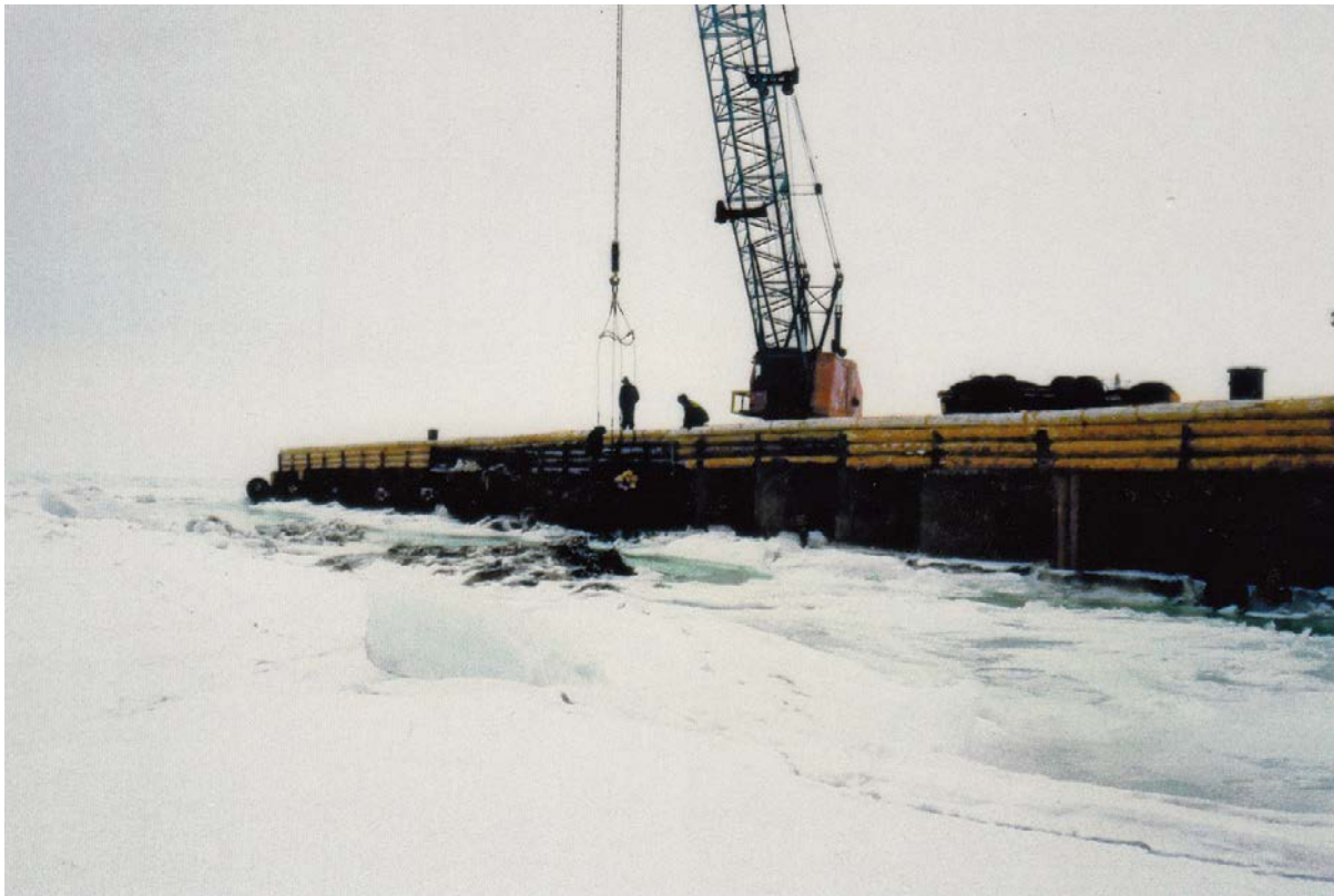
Laiturimuuri on rakennettu jatkuvaksi terässylinterien avulla.
