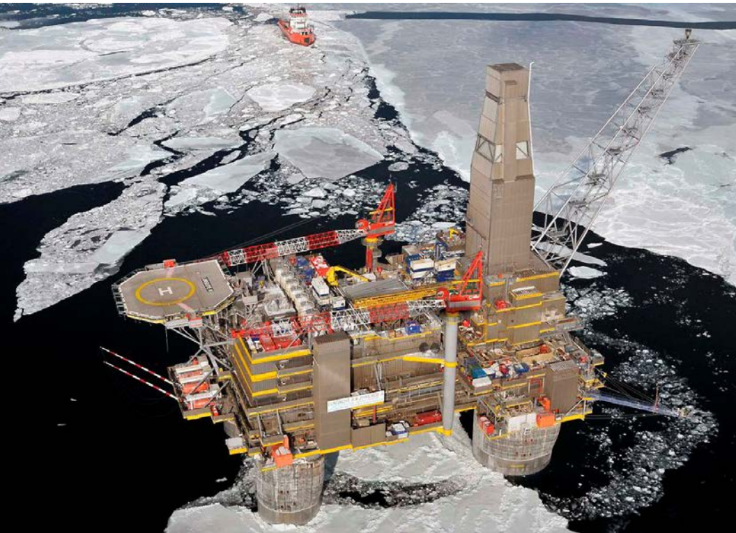
Myös öljynporaustasanne Ohotanmerellä värähteli jäiden vaikutuksesta. Aluksi jäänmurtajat rikkoivat lähestyviä jäälauttoja ja myöhemmin rakennetta korjattiin.
